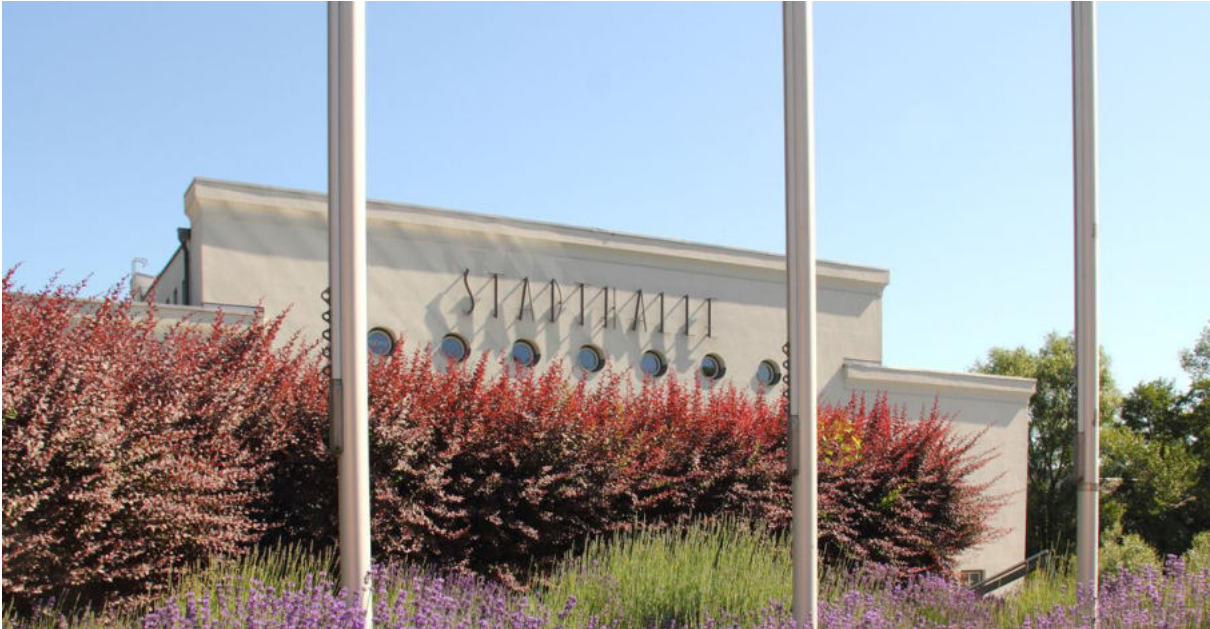
Abbildung 41: Stadthalle Bad Blankenburg (Quelle: Matthias Pihan)
